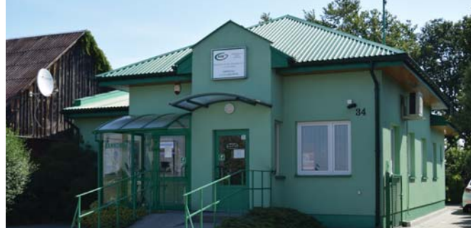
Budynek Rejonowego Banku Spółdzielczego w Lututowie Oddział w Czajkowie
